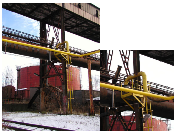
potrubní trasa koksového plynu, zemního plynu a parovodu z území aglomerace k D500
