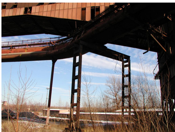
potrubní trasa koksového plynu, zemního plynu a parovodu z území aglomerace k D500
