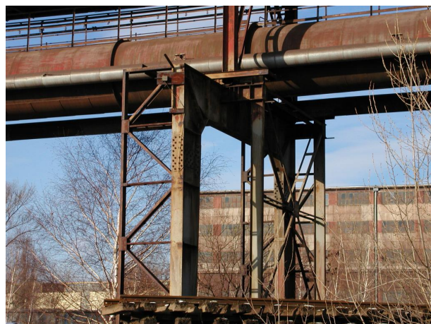
potrubní trasa koksového plynu, zemního plynu a parovodu z území aglomerace k D500
