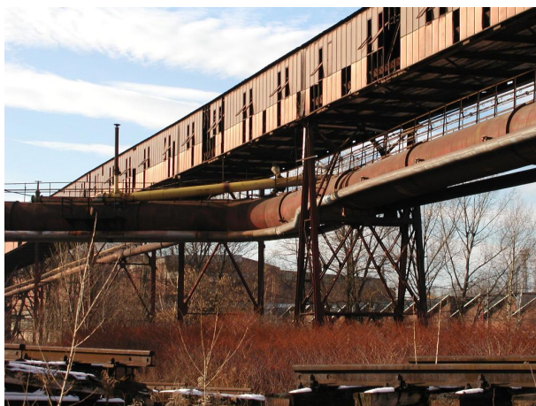
potrubní trasa koksového plynu, zemního plynu a parovodu z území aglomerace k D500
