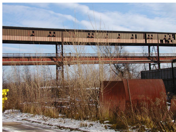
potrubní trasa koksového plynu, zemního plynu a parovodu z území aglomerace k D500
